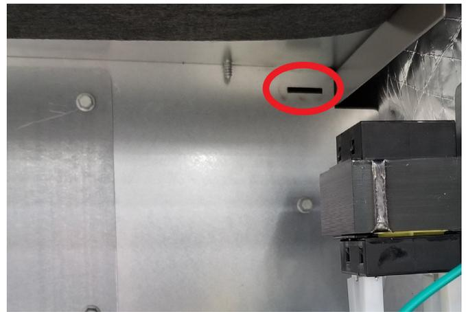
**FIGURA 18. Ranura para la reubicación del panel de control**
