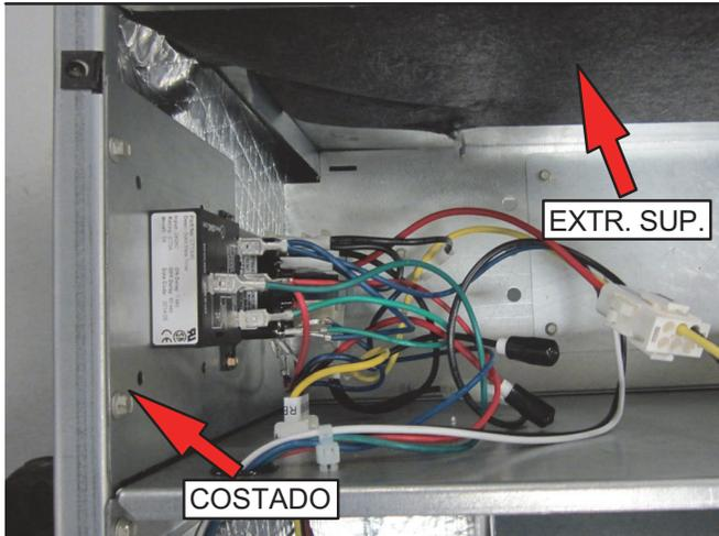
FIGURA 15. Conexiones eléctricas (configuración de flujo ascendente)
