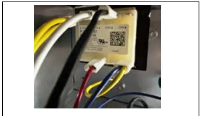
FIGURA 24. Conversión de la unidad de 230 VCA a 208 VCA
