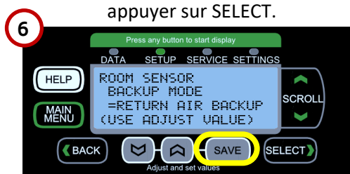
Utiliser les flèches grises pour choisir RETURN AIR BACKUP, appuyer sur SAVE.
