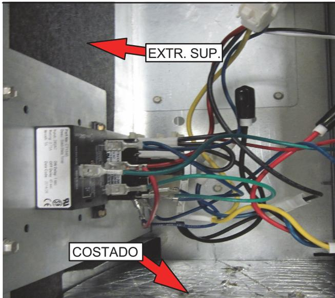
**FIGURA 19. Panel de control reubicado al panel extremo (configuración horizontal izquierda)**
