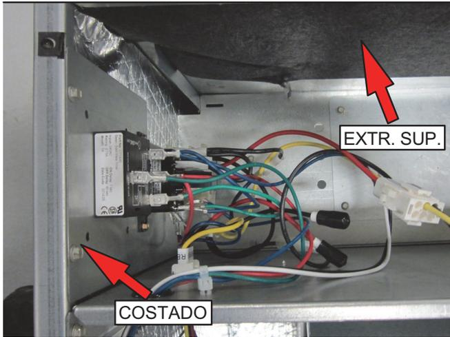
**FIGURA 18. Conexiones eléctricas (configuración de flujo ascendente)**
