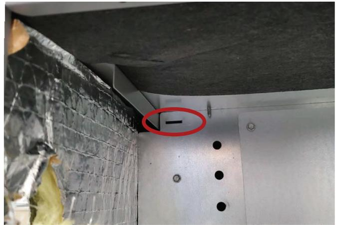
FIGURA 12. Ranura para la reubicación del panel de control
