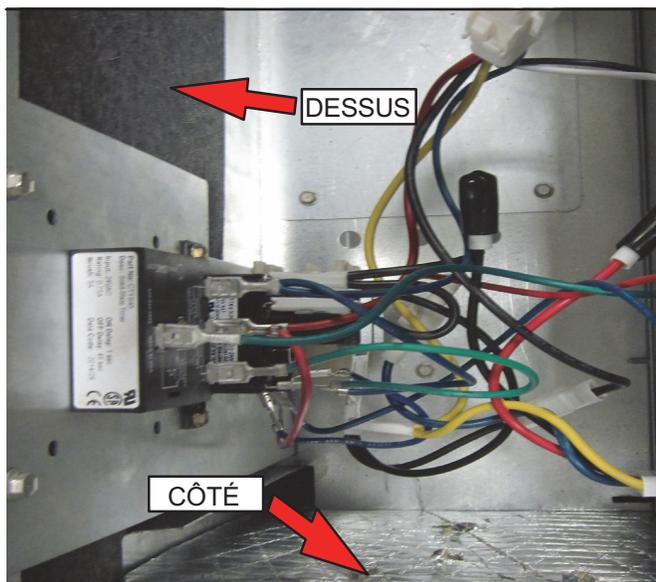
**FIGURE 19. Panneau de contrôle déplacé vers le panneau d'extrémité (Configuration horizontale avec refoulement par la gauche)**
