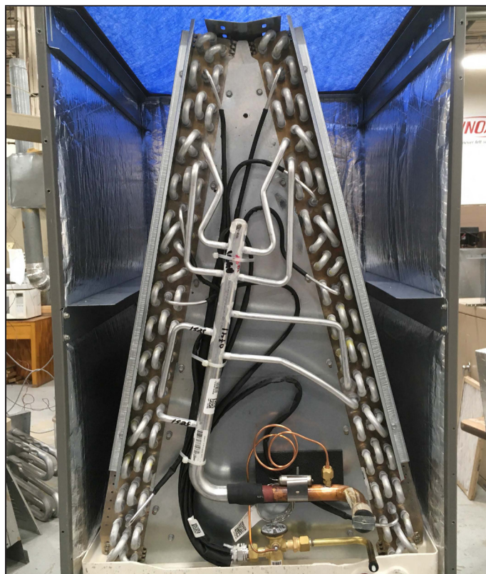
FIGURA 17. Instalación del deflector de aire de flujo descendente
