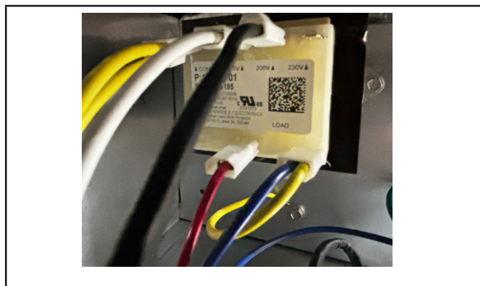
FIGURE 24. Conversion de l'unité de 240 VCA à 208 VCA
