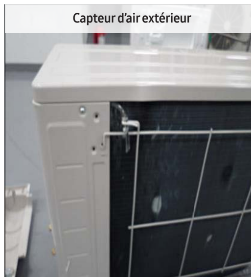
Testez avec des pointes de touche fines sur les 2 pattes argentées
