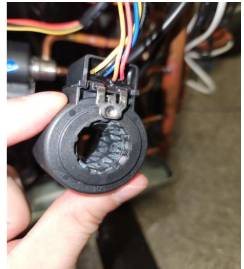
Figure 34. Retirez et inspectez la bobine de l'EEV à la recherche de rouille ou de corps étrangers
