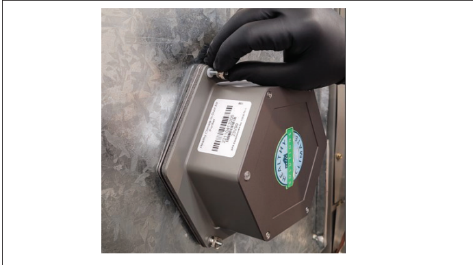
Figura 3. Hardware de instalación del pleno en el panel del conducto
