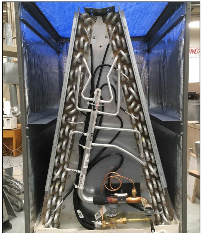
**FIGURE 17. Installation des chicanes pour configuration descendante**
