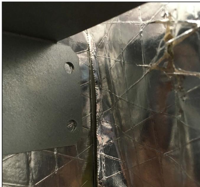
**FIGURE 16. Emplacement de la bride arrière de l'enceinte du VC**
